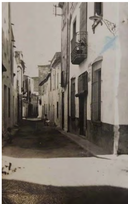
FIGURA 4. Vista de la casa de Fernando Benet al carrer de Sant Telm, núm. 25. Tossa de Mar, ca. 1915. Arxiu personal Elena Boissel Benet.
